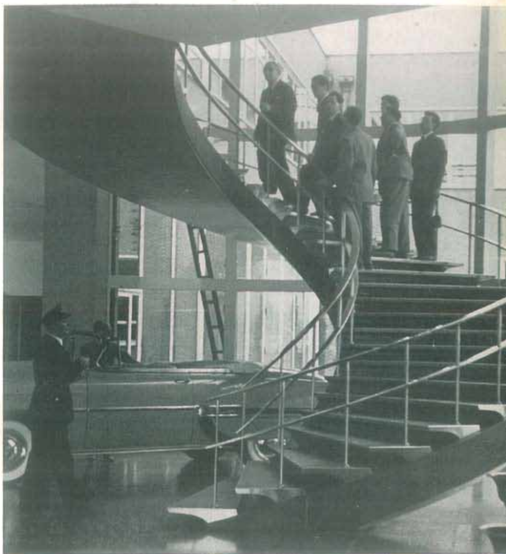
a sinistra: scala in c.a. nell'unità di abitazione a Marsiglia al centro: la realizzazione col c. a. delle strutture della scala, consente un minore ingombro delle murature ed esclude le condutture dalla struttura portante. a destra: la scala in c. a. precompresso di Magnel: soletta di cm. 28 di spessore incastrata al piede e in sommità.
