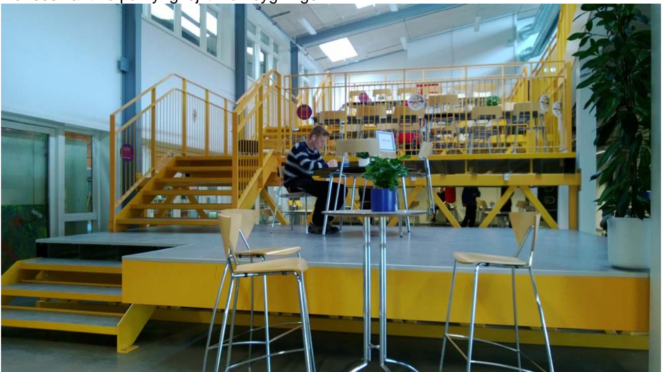
Nedbrydning af etagedæk, nye terrasser til ophold og nye ovenlys samt nyt kunstlys.
