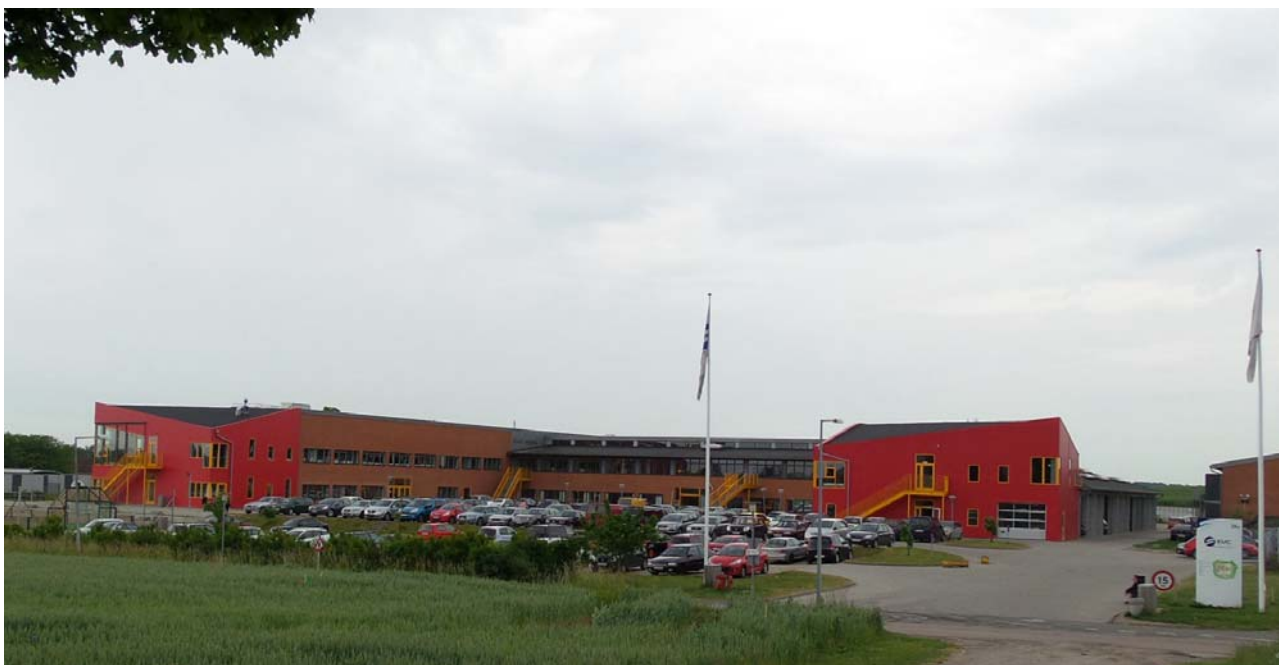
Her foto fra august 2014 efter at sidste etape med auto og SSI fløjen er færdigbygget.
